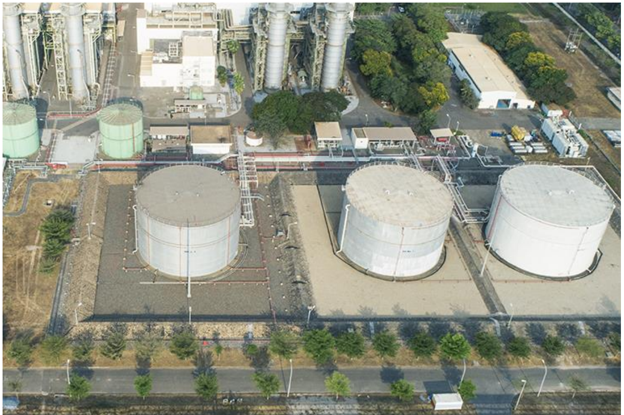
Рисунок 1.8 – Общий вид группы основных резервуаров с дизельным топливом в грунтовом обваловании на ТЭС «Фу Ми 1» в провинции Вунг Тау
