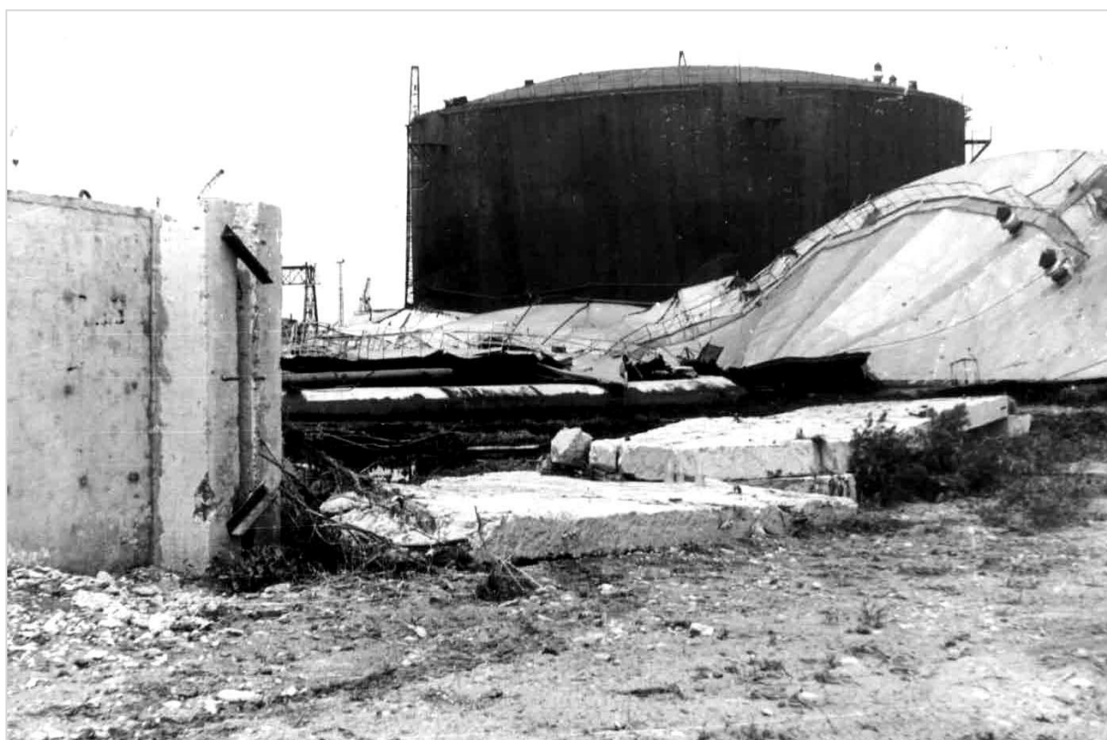
Рисунок 1.18 – Общий вид разрушенного железобетонного ограждения
