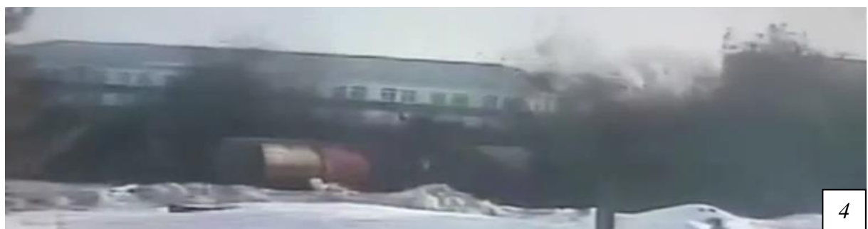
Рисунок 1.26 – Кадры видеосъемки разрушения РВС-2000 м 3 с битумом
