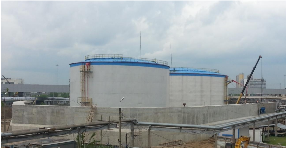
Рисунок 2.15 – Общий вид ограждающей стены с волноотражающим козырьком в резервуарном парке мазутного хозяйства ТЭЦ-11 (г. Москва)
