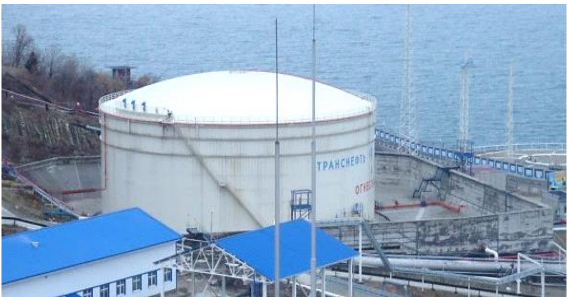
Рисунок 2.16 – Общий вид ограждающей стены с волноотражающим козырьком в резервуарном парке «Шесхарис» (г. Новороссийск)
