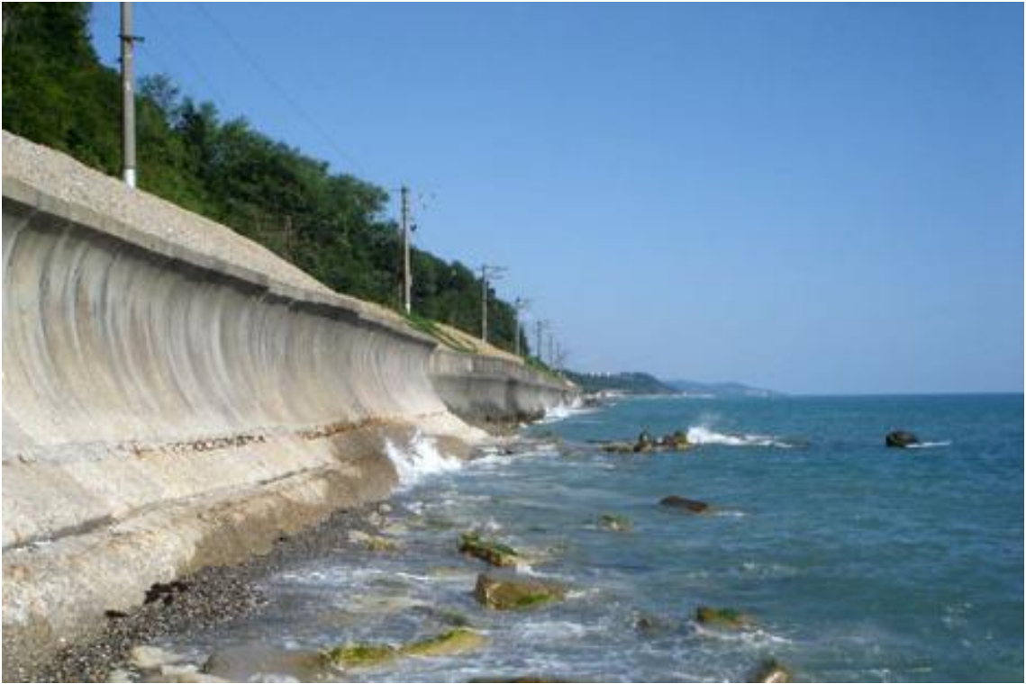
Рисунок 2.2 – Общий вид волноотбойной стены на Черноморском побережье РФ
