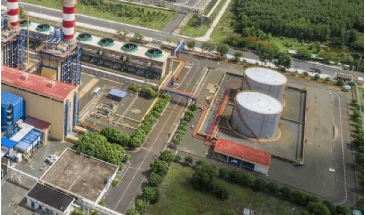
Рисунок 1.7 – Общий вид группы основных резервуаров с дизельным топливом в железобетонном ограждении на ТЭС «Ка Мау 1» в провинции Ка Мау
