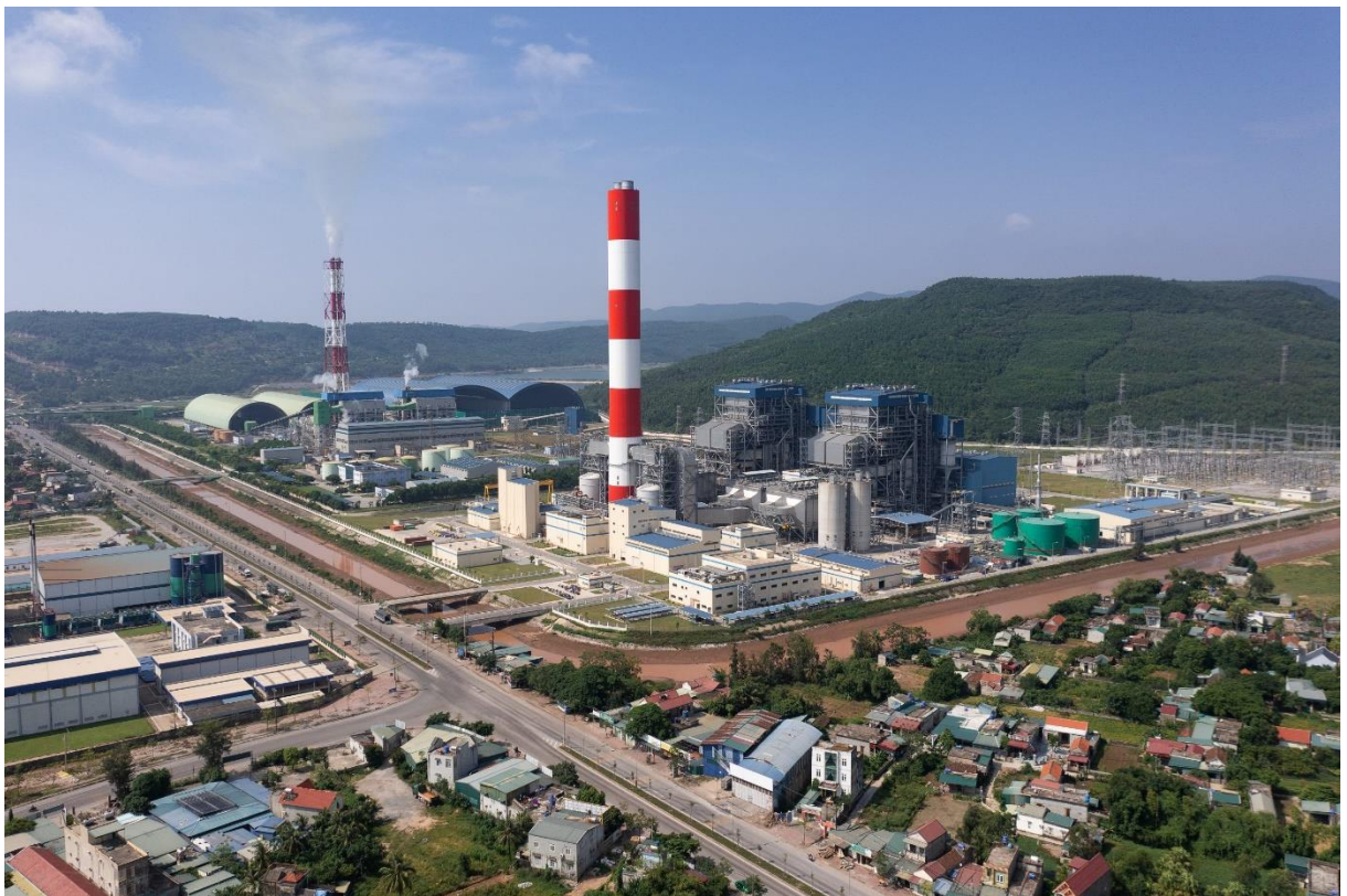
Рисунок 1.5 – Общий вид ТЭС «Нги Шон 2» в провинции Тхань Хоа, работающей на каменном угле (резервное топливо – мазут)
