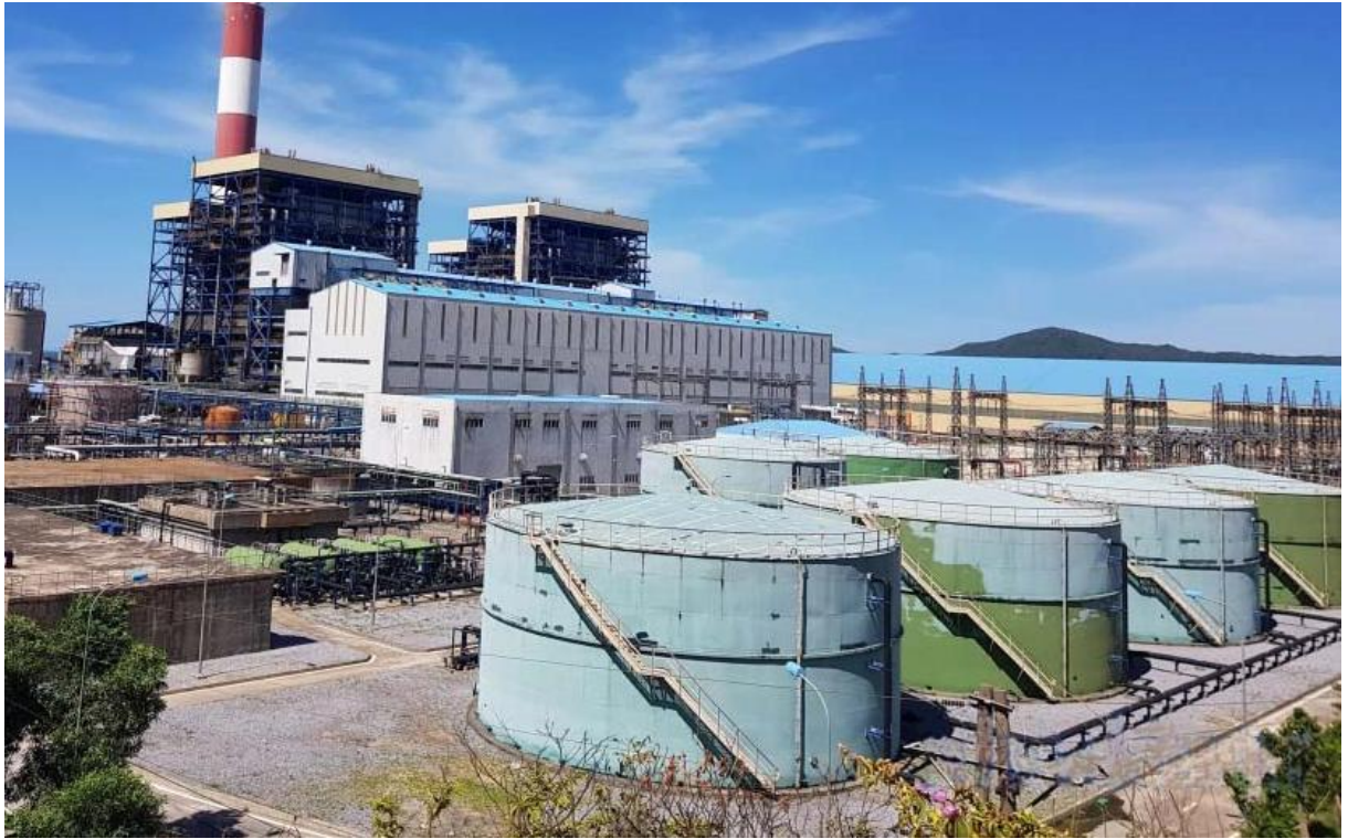
Рисунок 1.9 – Общий вид группы резервных резервуаров с мазутом на отбортованной площадке ТЭС «Вунг Анг 1» в провинции Ха Тинь
