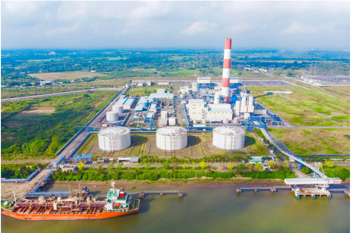
Рисунок 1.4 – Общий вид ТЭС «О Мон 1» в провинции Кан Тхо, работающей на природном газе (резервное топливо – мазут)
