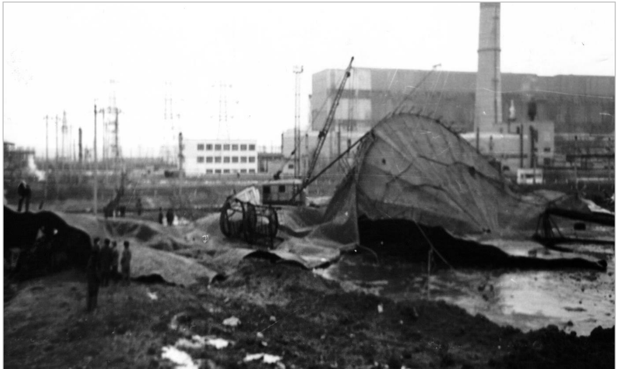
Рисунок 1.22 – Общий вид разрушенных РВС-10000 м 3
