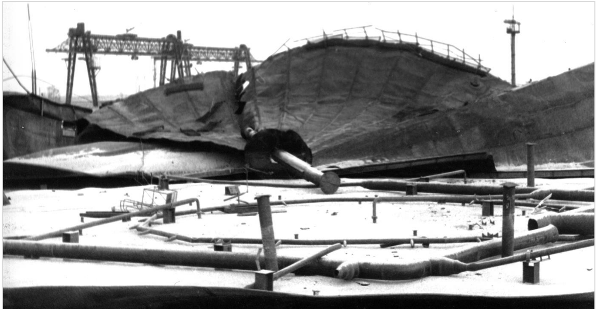
Рисунок 1.20 – Положение фрагмента крыши с центральной стойкой разрушенного РВС-20000 м 3
