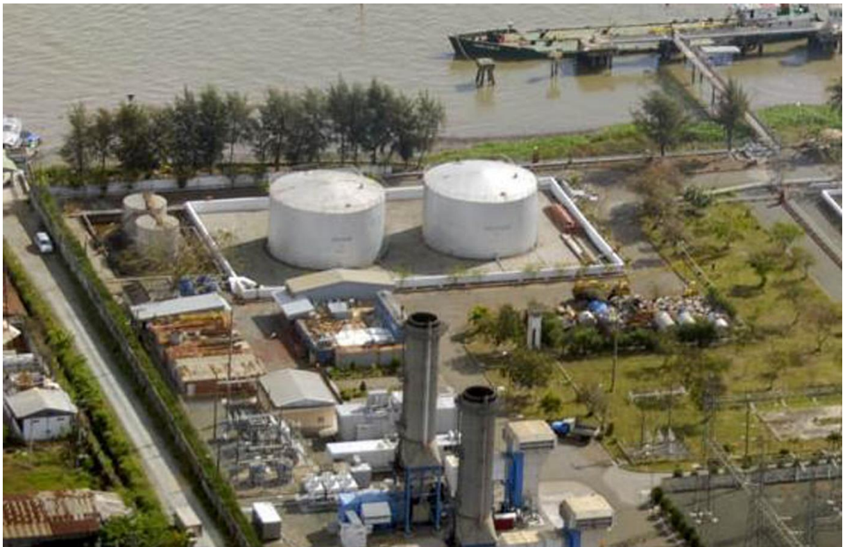
Рисунок 1.6 – Общий вид группы резервных резервуаров с мазутом в железобетонном ограждении на ТЭС «Ча Нок» в провинции Кан Тхо
