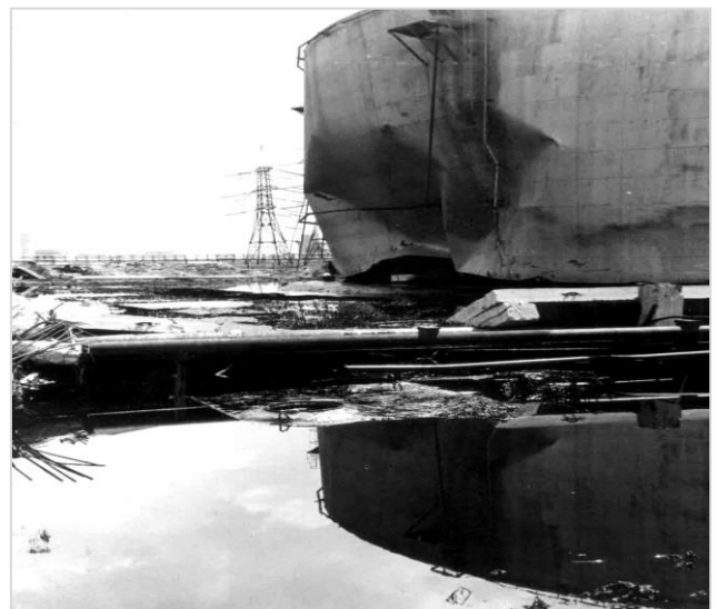
Рисунок 1.17 – Общий вид поврежденного РВС № 3
