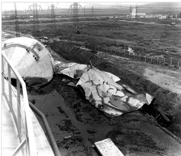
Рисунок 1.16 – Общий вид РВС № 2 после разрушения
