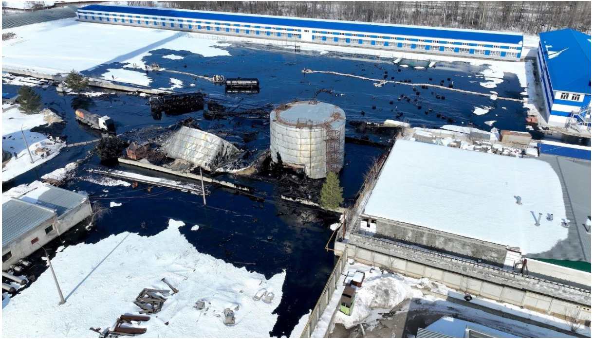
Рисунок 1.27 – Последствия разрушения резервуара с битумом
