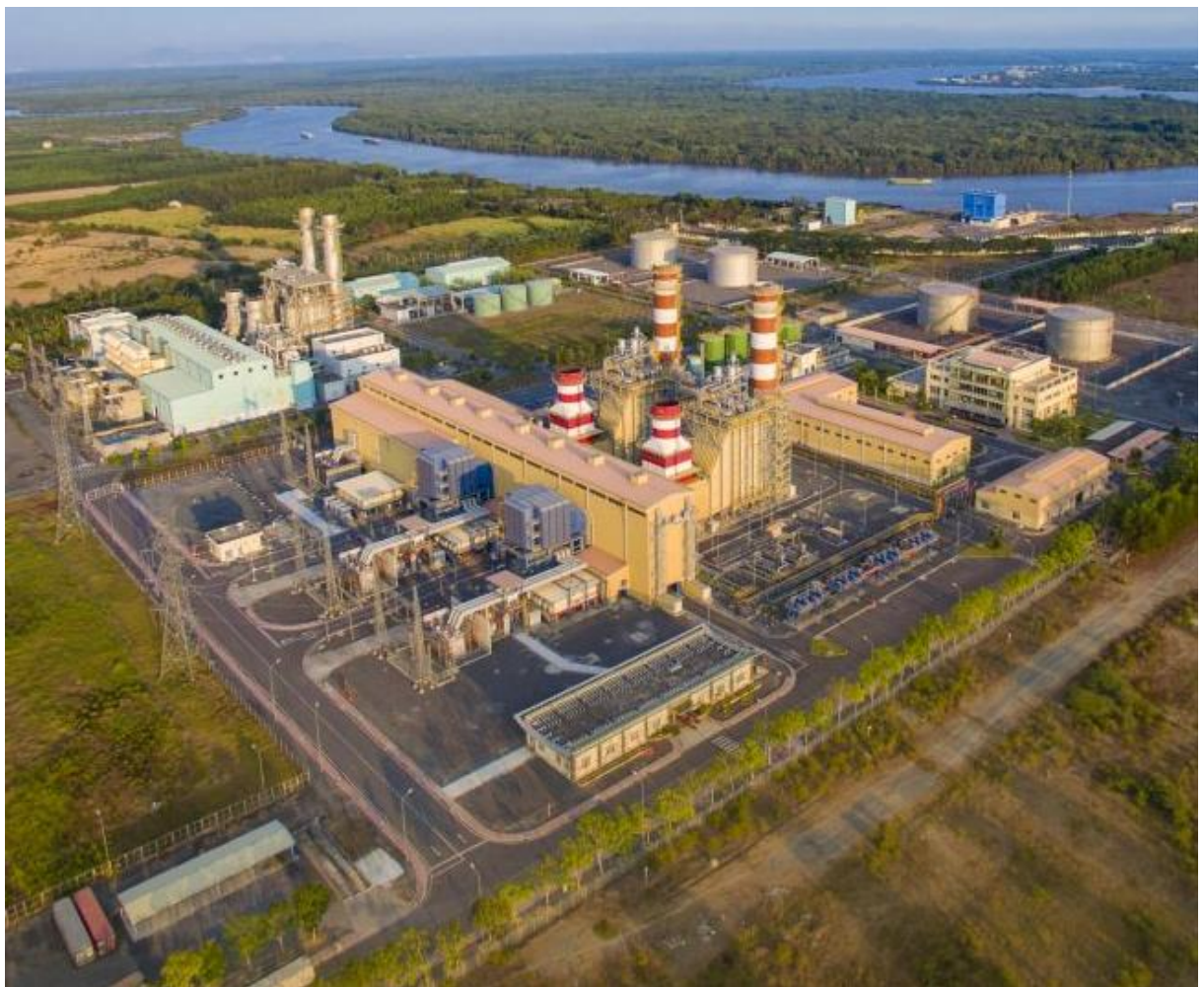
Рисунок 1.3 – Общий вид ТЭС «Ньон Чать 2» в провинции Донг Най, работающей на природном газе и дизельном топливе (резервное топливо – дизельное топливо)
